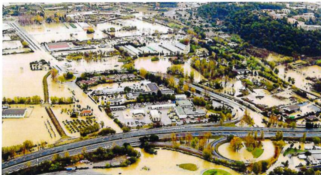
Figure 19 : Inondation de la Siagne en novembre 2011 (Source : Nice Matin – Photo G.T.)
