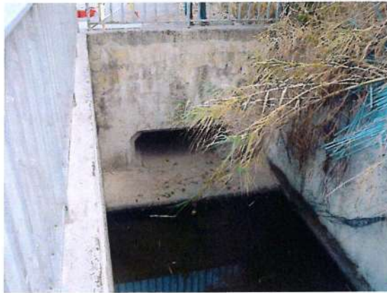
Figure 9 : Vallon des Crottes à ciel ouvert (dégraisseur) au croisement de l'Avenue du Général Garbay et de la Rue de Bocri
